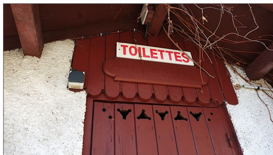
Plaque de toiture
