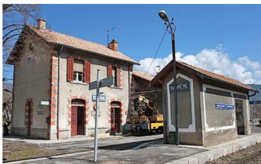
Gare de Barrême
